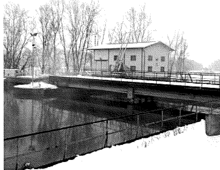
La nuova centrale idroelettrica in località Due Acque sul colatore Belgiardino a Montanaso
