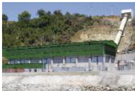
IMPIANTO ECOCOMPATIBILE Un particolare della centrale idroelettrica di Lircay in Cile, realizzata da Ste Energy
